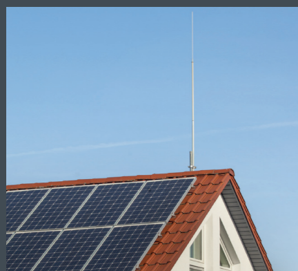
▲ Obr. 4: Instalace systému DEHNcon-H s integrovaným vodičem HVI light. Zdroj: Tiskopis DS212/CZ/0114.
