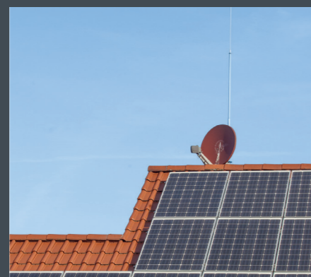
▲ Obr. 4: Instalace systému DEHNcon-H s integrovaným vodičem HVI light. Zdroj: Tiskopis DS212/CZ/0114.
